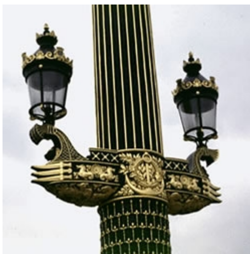
Paris, place de la Concorde, colonne rostrale après restauration : protection anticorrosion par un système glycérophthalique, décor avec une dorure à la mixtion Cliché J.-P. Bozellec
